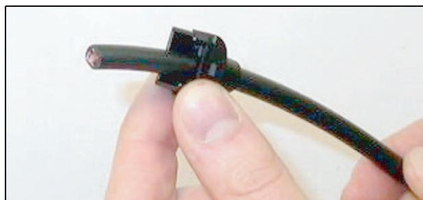
figura 20.6: Posizionamento del retro dell'involucro sul cavo
