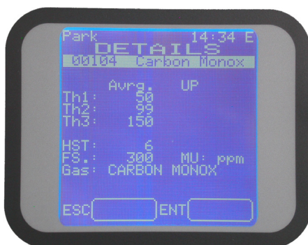
Figura 42) Dettagli configurazione rilevatore gas
